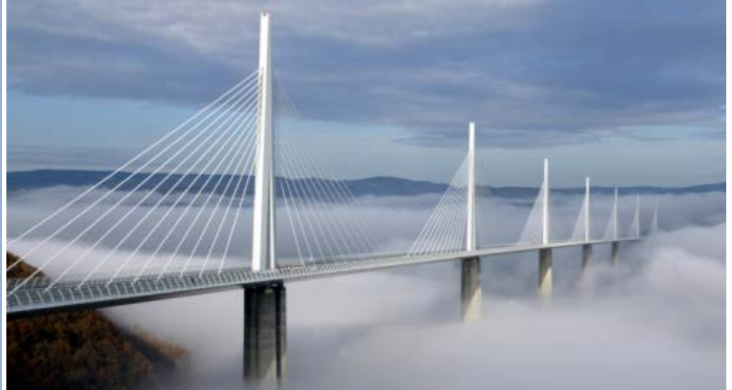
Grande Viaduc de Millau - ein Bauwerk der Superlative. Die 2460 Meter lange Schrägseilbrücke im Süden des französischen Zentralmassivs westlich der Stadt Millau und ist die höchste Autobahnbrücke der Welt. (Quelle: http://www.zdf.de/ZDFmediathek/beitrag/bilderserie/112560/Moderne-Bruerken-Konstruktionen/#/beitrag/bilderserie/112560/Moderne-Bruerken-Konstruktionen )
